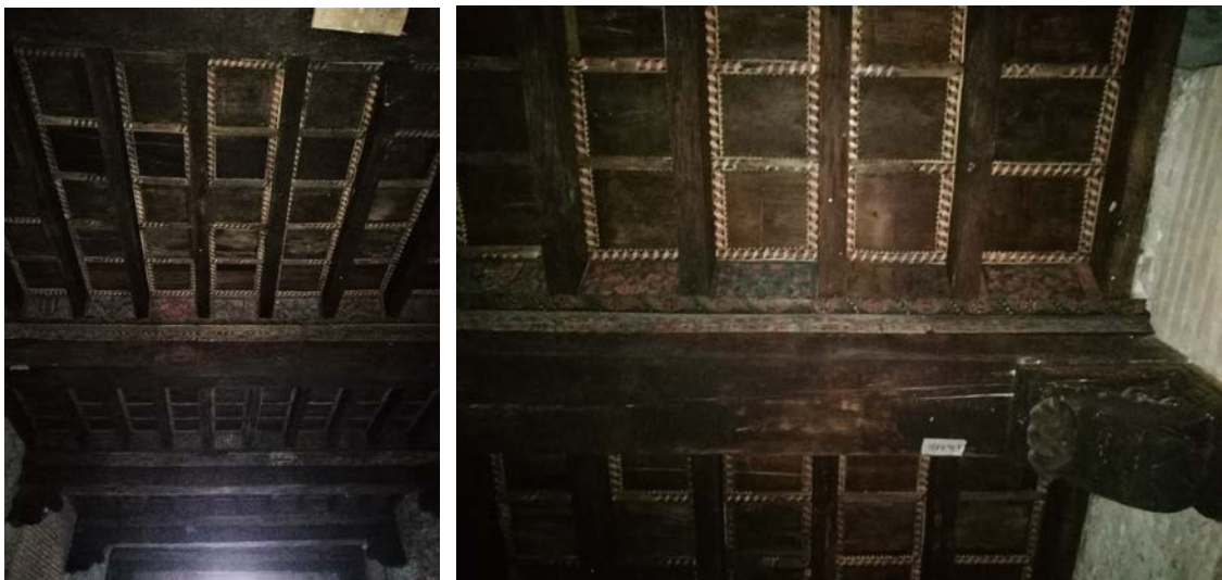
Soffitto ligneo nel primo piano del Palazzo Pier Mattei Albertoni, visione d'insieme e nel dettaglio
