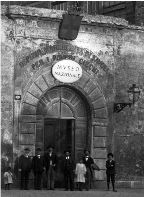
11. L'ingresso in "coabitazione" del nuovo Museo Nazionale dal Portale della Certosa, posto sul lato sud dell'Aula IX, demolito prima del 1911
