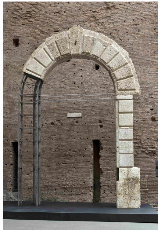
12. Il Portale della certosa cinquecentesca – originariamente posto sul lato sud dell'Aula IX - parzialmente ricomposto e attualmente collocato nell'Aula VIII
